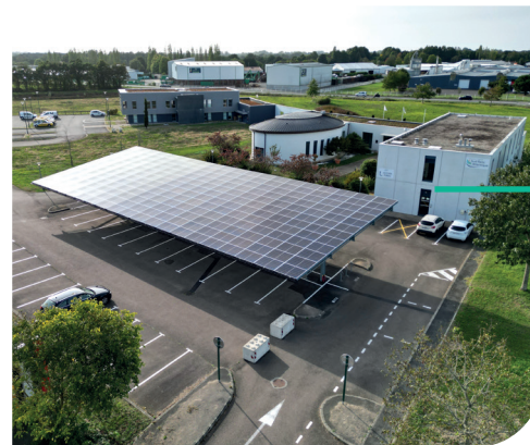
> Ombrières de la Communauté de communes Sud Retz Atlantique
